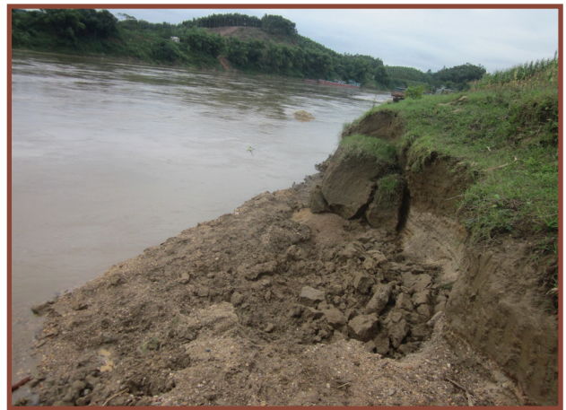
Hình 3.3. Khai thác cát gây sạt lở đất tại xã Đội Bình, huyện Yên Sơn, tỉnh Tuyên Quang
